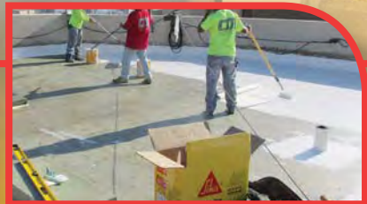
Apply Base Coat Over Primer
